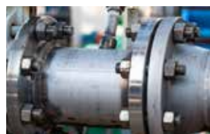
CONSTRUCCIÓN DE INSTALACIONES
